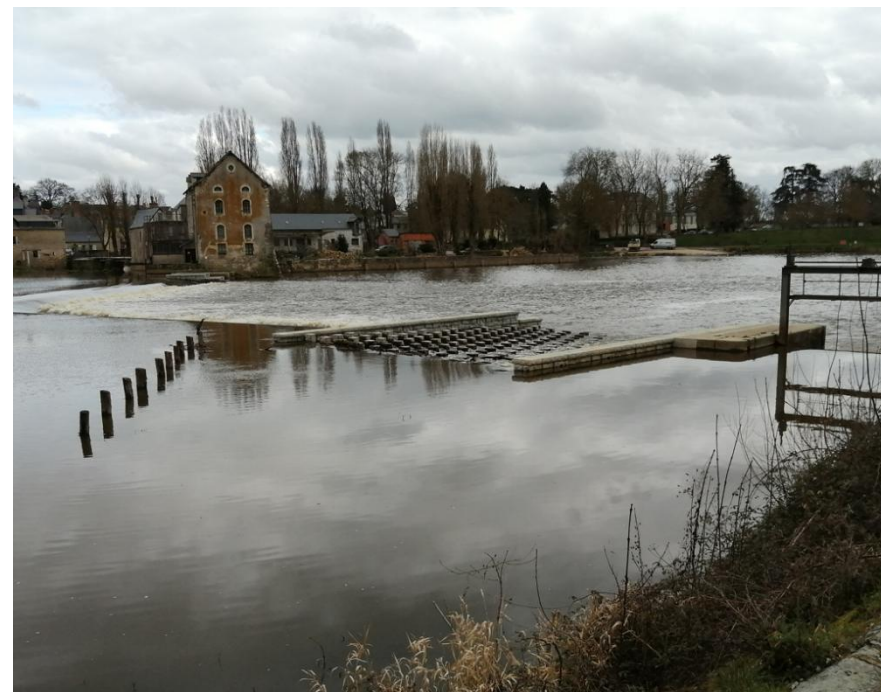
Figure 103 : Passe à macrorugosités de Grez-Neuville (Mayenne) (Source : CD49)
