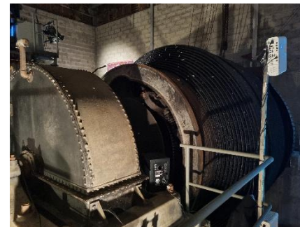
Machinerie des ardoisières et chevalement La Pouëze (Erdre-en-Anjou)
