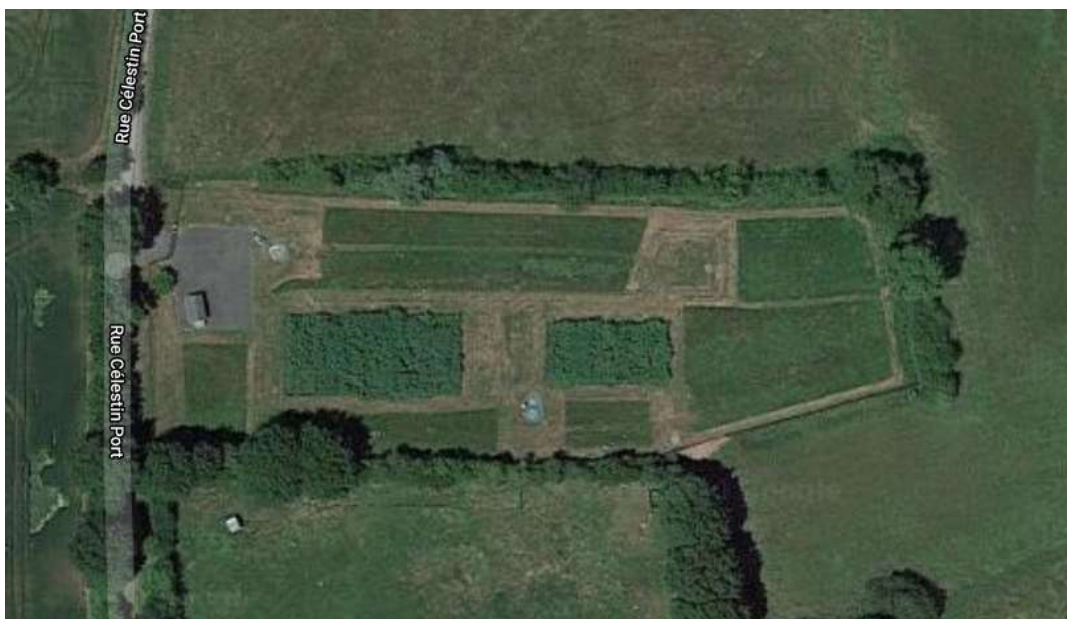
Station de traitement
