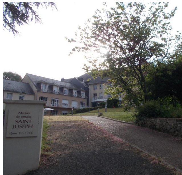
Photo de la maison de retraite Saint-Joseph dans le bourg de Chenillé
