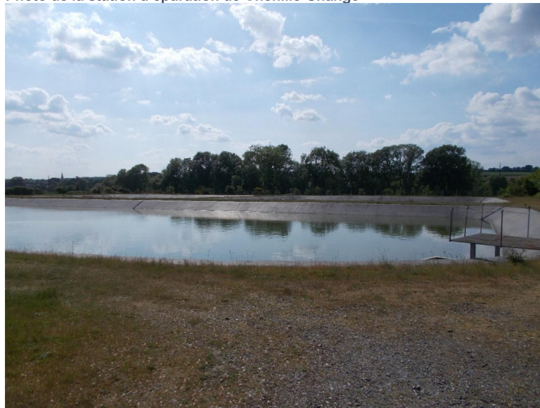
Photo de la station d'épuration de Chenillé-Changeé
