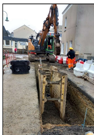
Photo 5 : Travaux réseaux EU du Bourg de Miré
