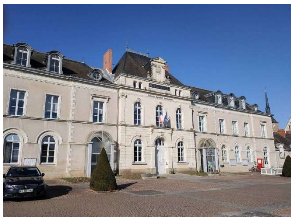
Photo 1 : siège de la CCVHA
