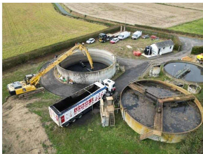
Photo 3 : opération d'évacuation de boues compactes - Vern d'Anjou
