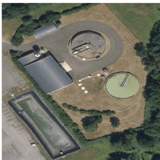
Photo 2 : Station d'épuration du Lion d'Angers
