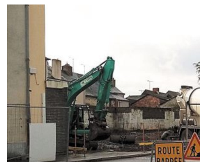
Une déviation a été mise en place rue Brossay-du-Perray. | PHOTO : OUEST-FRANCE
