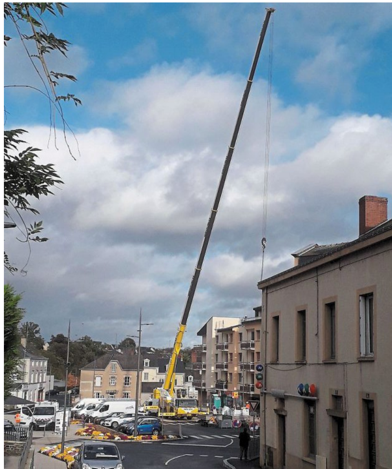
Lundi, cette énorme grue, place de la République, en a surpris plus d'un par sa taille. Elle était là, non pas pour les travaux du centre-ville qui sont quasiment terminés, mais pour évacuer les déchets produits lors de la rénovation de l'étanchéité des terrasses de la résidence des Variétés. | PHOTO : OUEST-FRANCE
