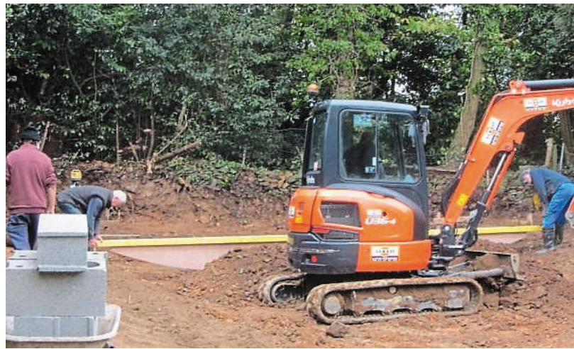
Tracteur, mini-pelle, brouettes ont envahi le terrain de boules de fort. Le dernier terrain en terre battue, à ciel ouvert, du Maine-et-Loire, est en travaux. Les adhérents ont retroussé leurs manches depuis plusieurs jours. | PHOTO : OUEST-FRANCE
