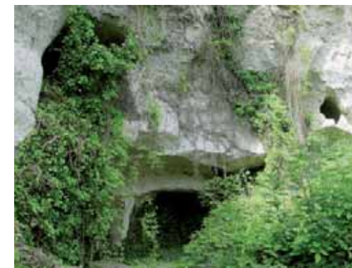
DÉFAUT D'ENTRETIEN DE LA VÉGÉTATION
