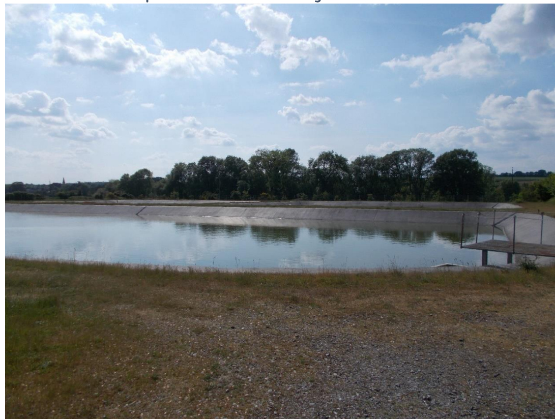
Photo de la station d'épuration de Chenillé-Changé
