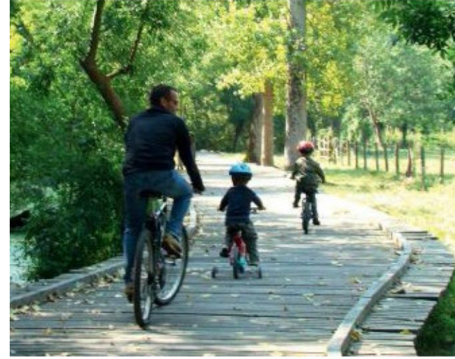
Tronçons sur pilotis (bois/métal) permettant de ne pas dénaturer le sol/la berge et d'apporter un intérêt pédagogique aux séquences traversées
