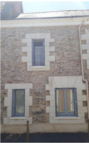
Les éléments de modénature comprennent les corniches et bandeaux, les encadrements de baies et les chaînages d'angle en pierre de taille, les lucarnes...
