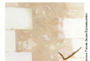
L'enduit à pierre vue harmonise les différents éléments du mur, entre moellons et pierres de taille.
