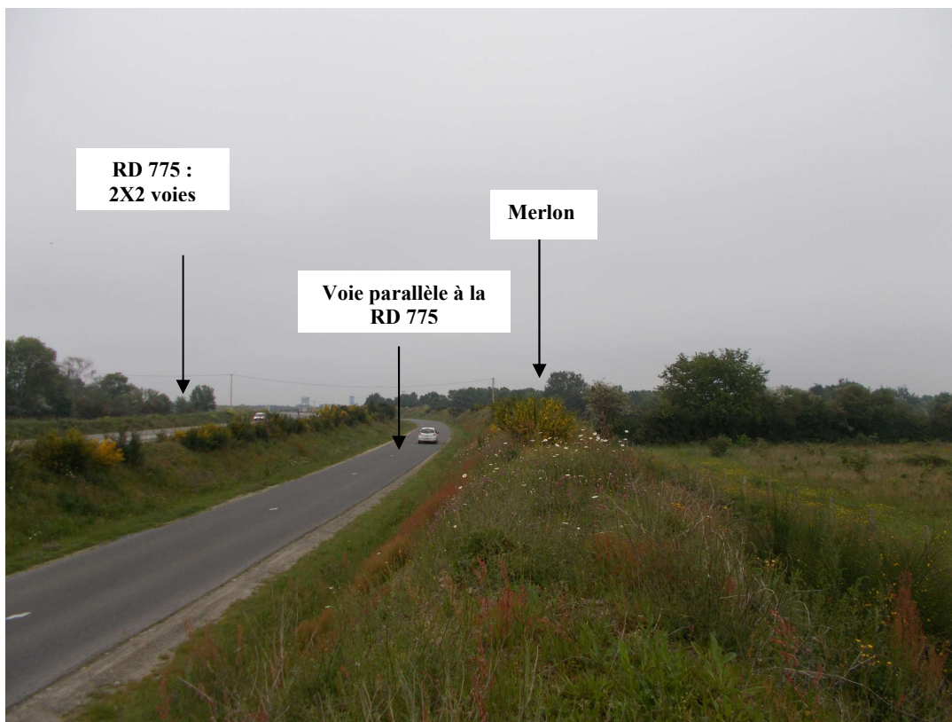
Vue sur la voie parallèle à la RD 775 en provenance de Grez Neuville (voie de desserte du site)
