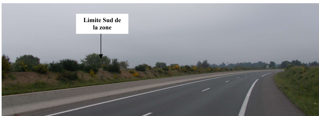
Vue en provenance du Lion d'Angers (3) – Le talus le long de la RD 775 obture les perspectives – il devient légèrement moins haut dès que l'on a dépassé la zone
