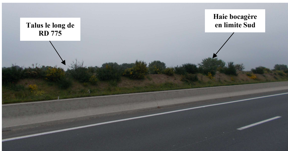
Vue en provenance du Lion d'Angers (2) – Le talus le long de la RD 775 obture les perspectives – Au second plan on aperçoit la cime des arbres de la haie au sud du site.
