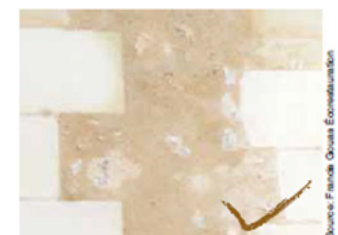
L'enduit à pierre vue harmonise les différents éléments du mur, entre moellons et pierres de taille.
