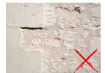
Ici, l'enduit couvrait initialement les moellons. Le rejointoiement n'est donc pas adapté puisqu'on retrouve les traces de piquage et la surépaisseur des pierres de taille de la chaîne d'angle.
