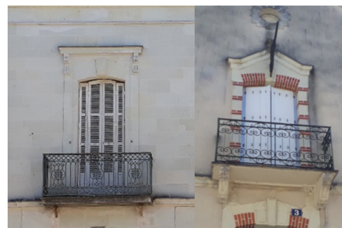
Guide de recommandations : restauration des façades
