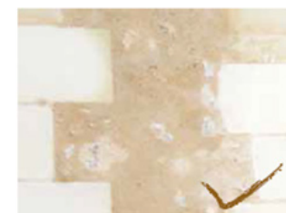
L'enduit à pierre vue harmonise les différents éléments du mur, entre moellons et pierres de taille.
