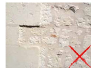
Ici, l'enduit couvrait initialement les moellons. Le rejointoiment n'est donc pas adapté puisqu'on retrouve les traces de piquage et la surépaisseur des pierres de taille de la chaîne d'angle.
