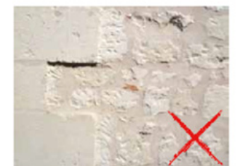
Ici, l'enduit couvrait initialement les moellons. Le rejointoiment n'est donc pas adapté puisqu'on retrouve les traces de piquage et la surépaisseur des pierres de taille de la chaîne d'angle.
